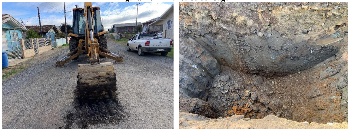
Figura 1 e 2 – Furos de Sondagem
